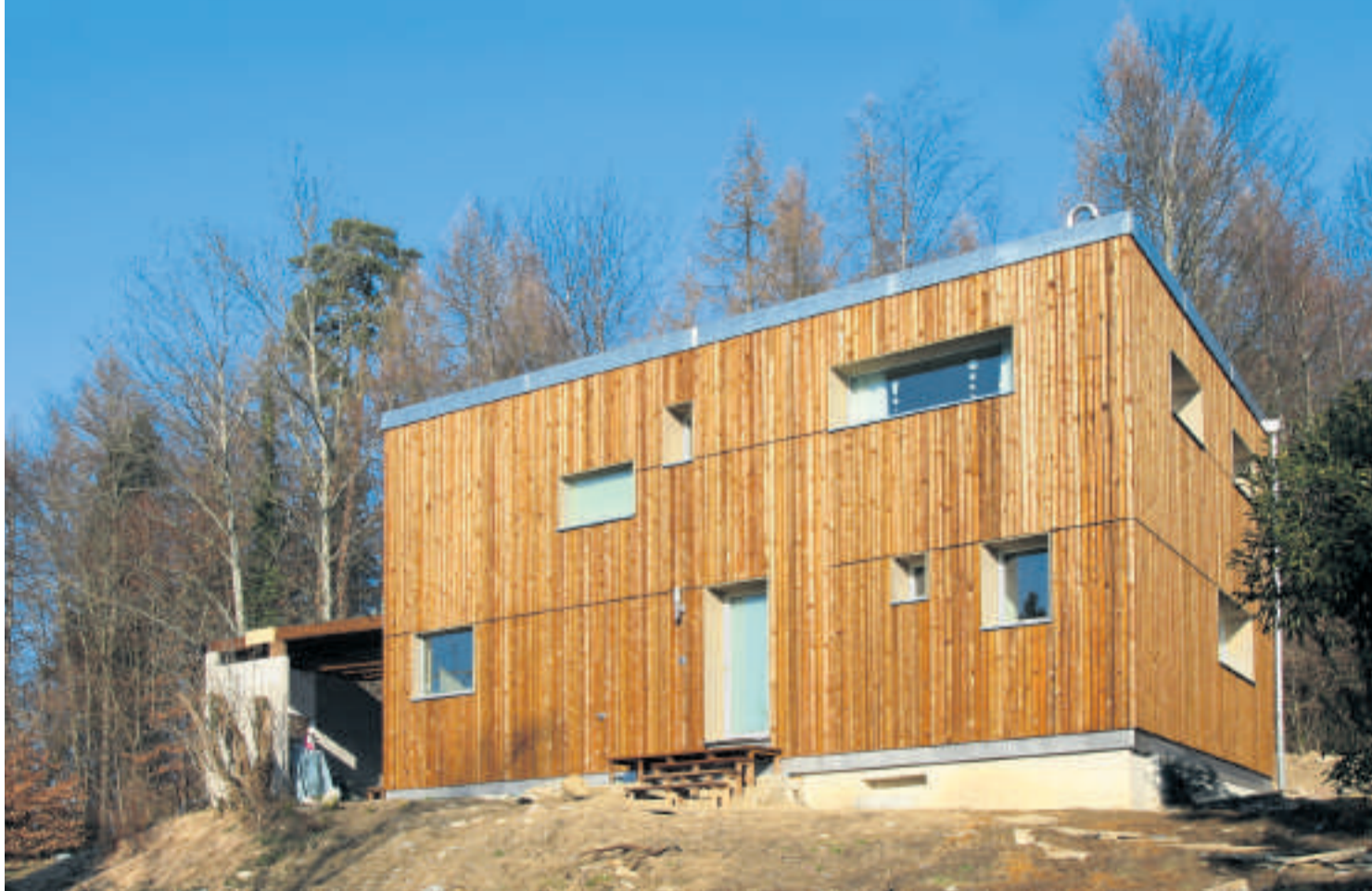
Unbehandeltes Fichtenholz im Innern, massive Blockholzelemente für die Konstruktion: Viel gestalterische Freiheit für die Architekten
